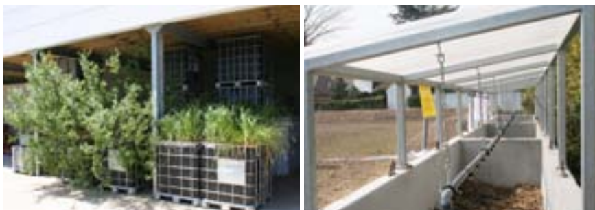
Le biofiltre et le phytobac dégradent l'eau résiduelle selon des procédés biologiques (© Boerenbond & Landelijke Gilden) (Source : PC Fruit-DAT-CdS).
