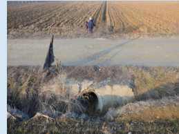
Court-circuit vers la rivière par buse de drainage
